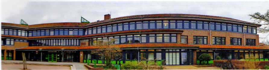
Dila verkleidete 3000 Fenster- und Türelemente des Kreishauses Wildeshausen (D) mit Aluschalen.
